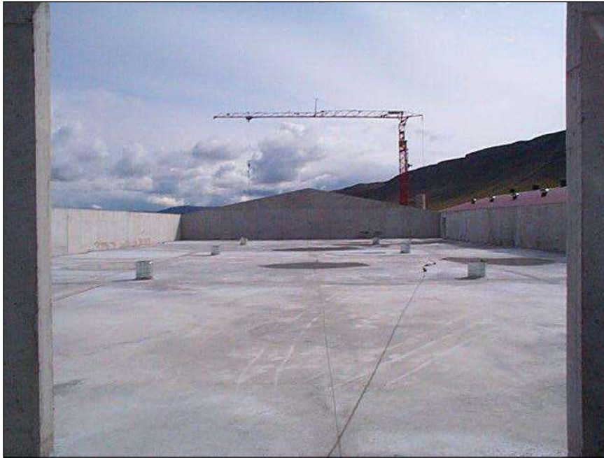
MYND 2.6 Horft inn í eldishús 2 að Hurðarbaki meðan það var í byggingu.
